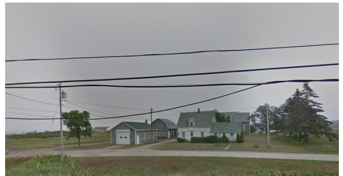
Figure 1: Photo of 23 Chemin du Pont du Marais
